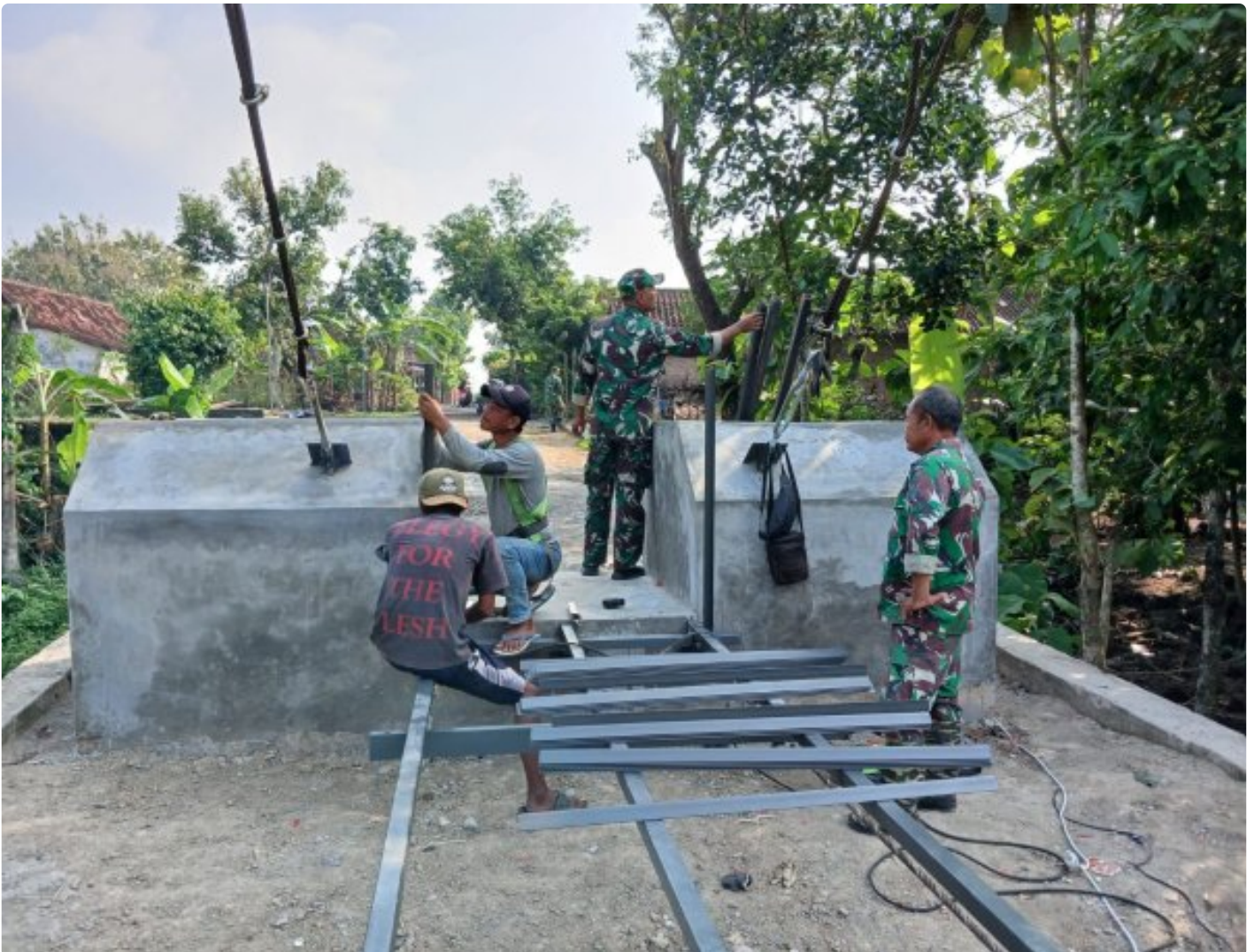
Sinergi TNI dan Warga Warnai Pemasangan Railing Jembatan Gantung Garuda Karangpaket
