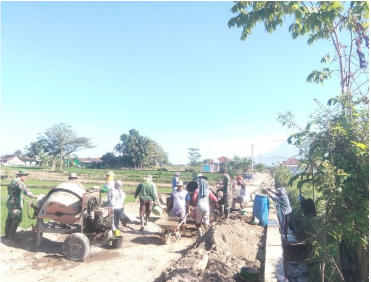
Program KBMKB Ke-35: Koramil 11/Karangnongko Bersama Warga Kebut Betonisasi Jalan Pertanian Desa Somokaton
