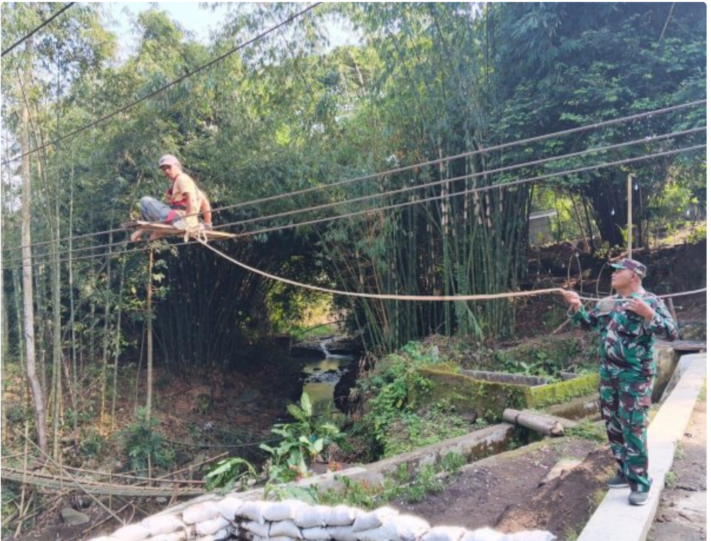
Pemasangan Hanger Pengait Jembatan Gantung Garuda Di Desa Kranggan Terus Dikebut
