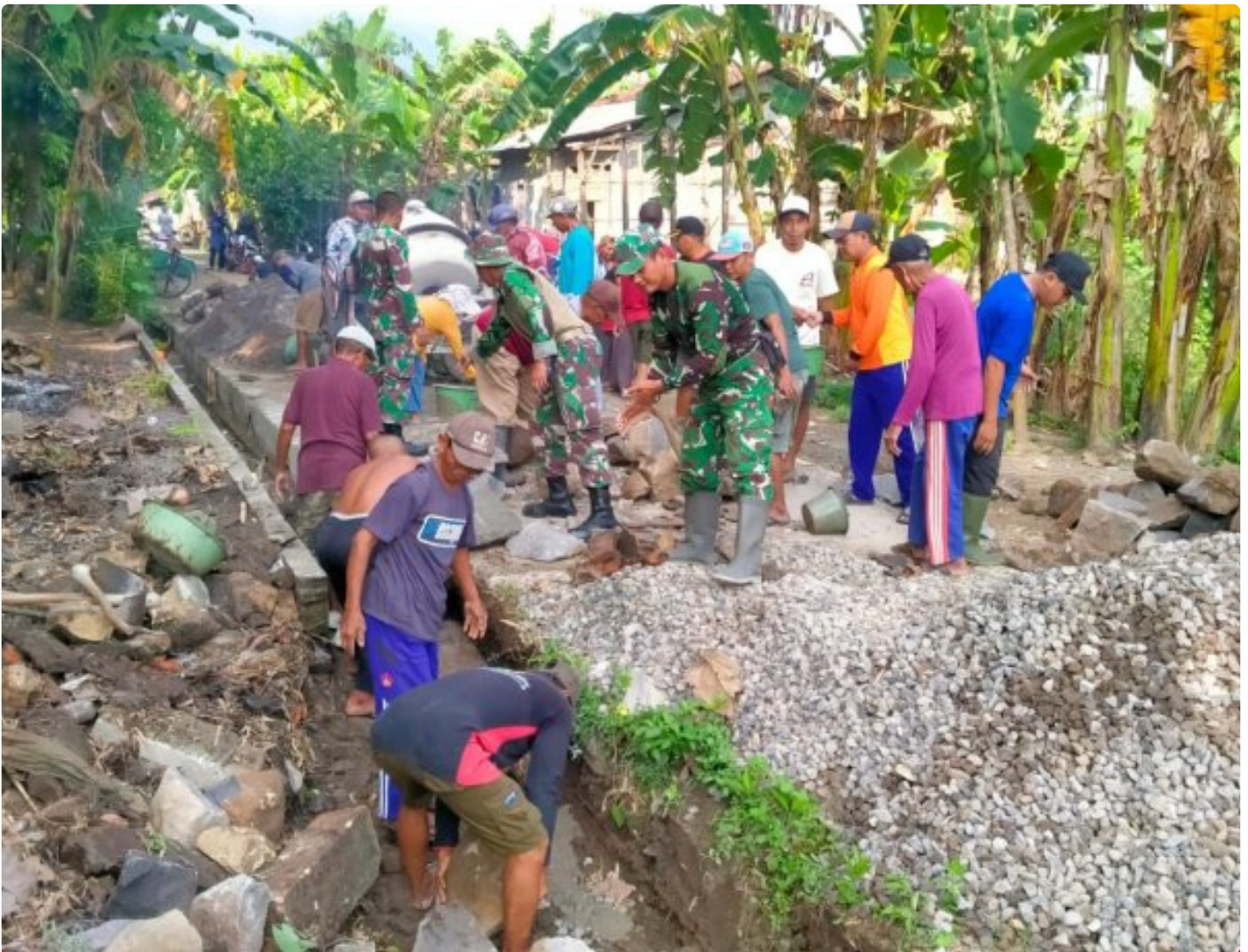
Koramil 20/Cawas Dan Warga Bangun Talud Penunjang Akses Jembatan Garuda
