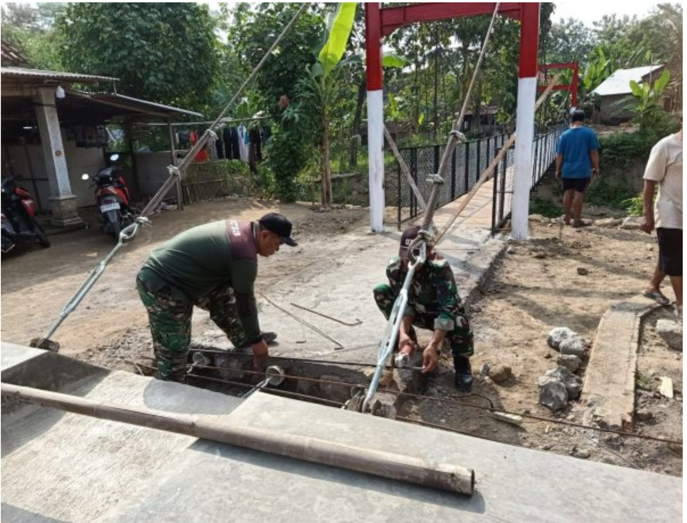
Koramil 18/Bayat Bersama Warga Percepat Pekerjaan Jembatan Gantung Garuda
