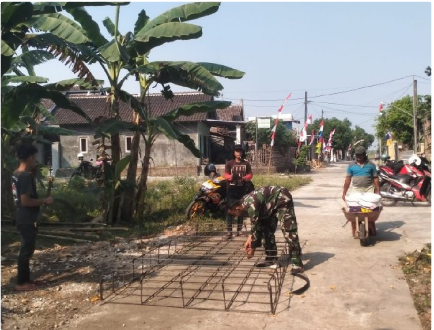
Jembatan Garuda: TNI Dan Warga Perkuat Akses Penghubung Desa Bener
