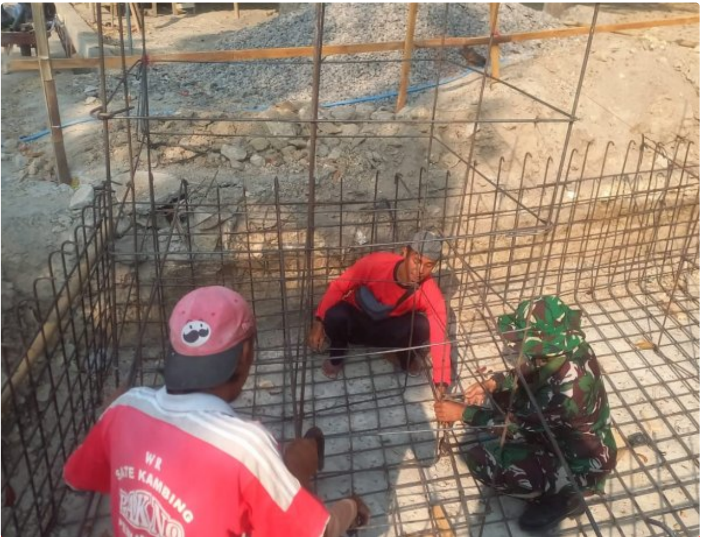
Jembatan Garuda Tahap VI di Kalikotes Masuki Pengerjaan Balok Gandul Dan Pylon, TNI Bersama Warga Perkuat Akses Antarwilayah
