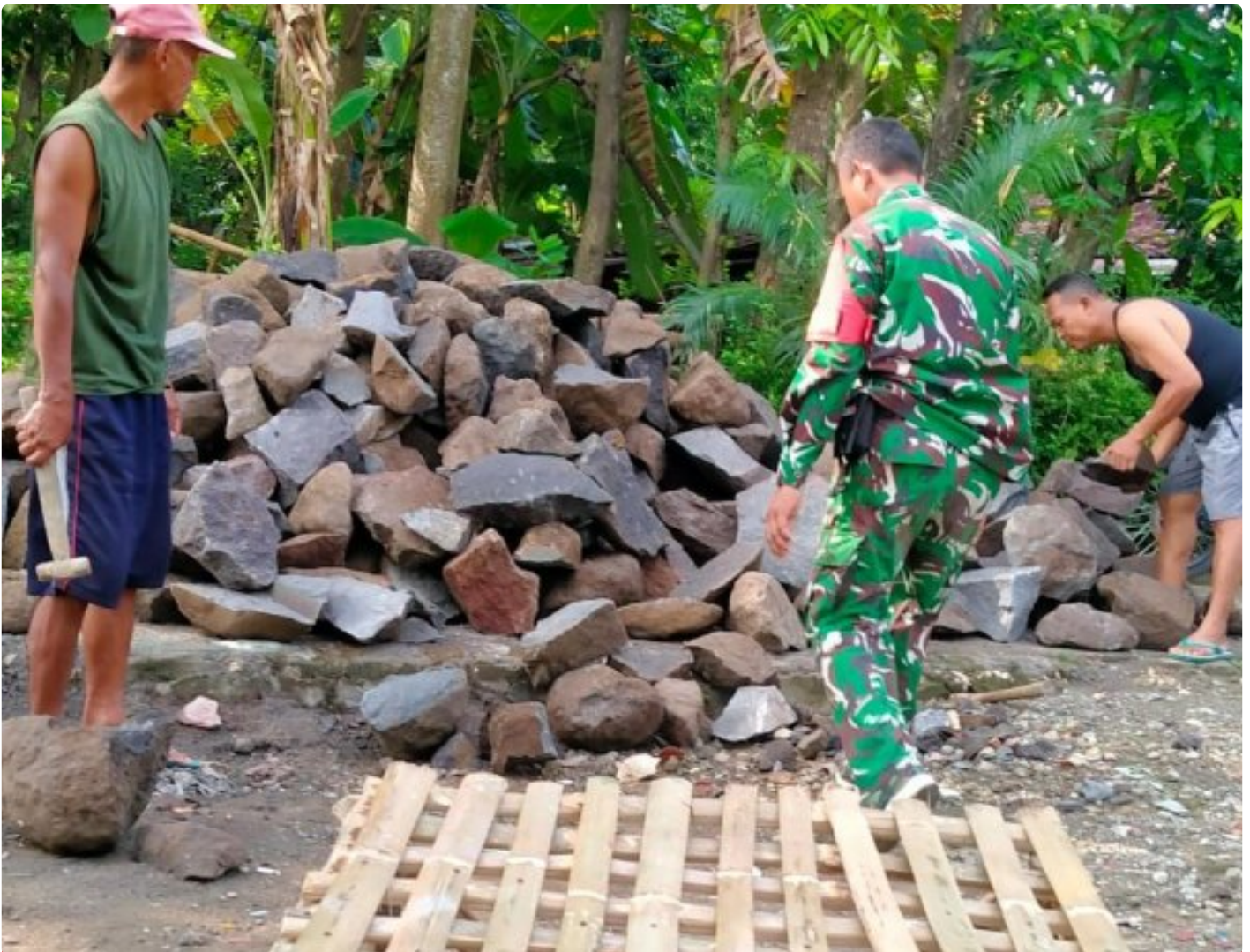
Gotong Royong Warga Dan Babinsa Percepat Pembangunan Jembatan Garuda
