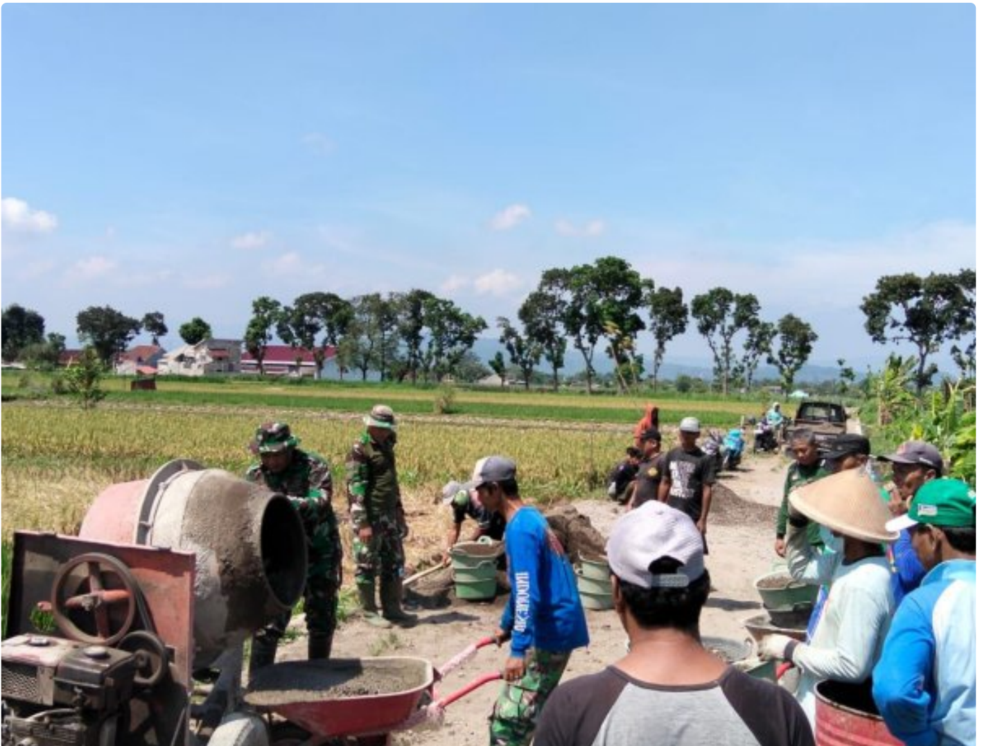
Gotong Royong TNI-Rakyat Warnai Pengecoran Jalan TMMD Di Desa Solodiran Klaten
