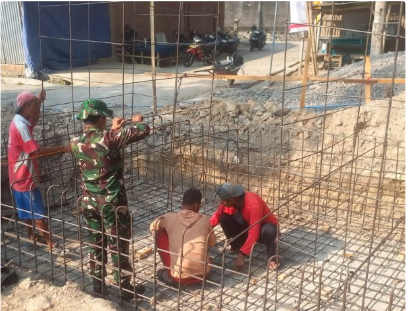
Gotong Royong TNI dan Warga Warnai Pembangunan Jembatan Garuda Kalikotes
