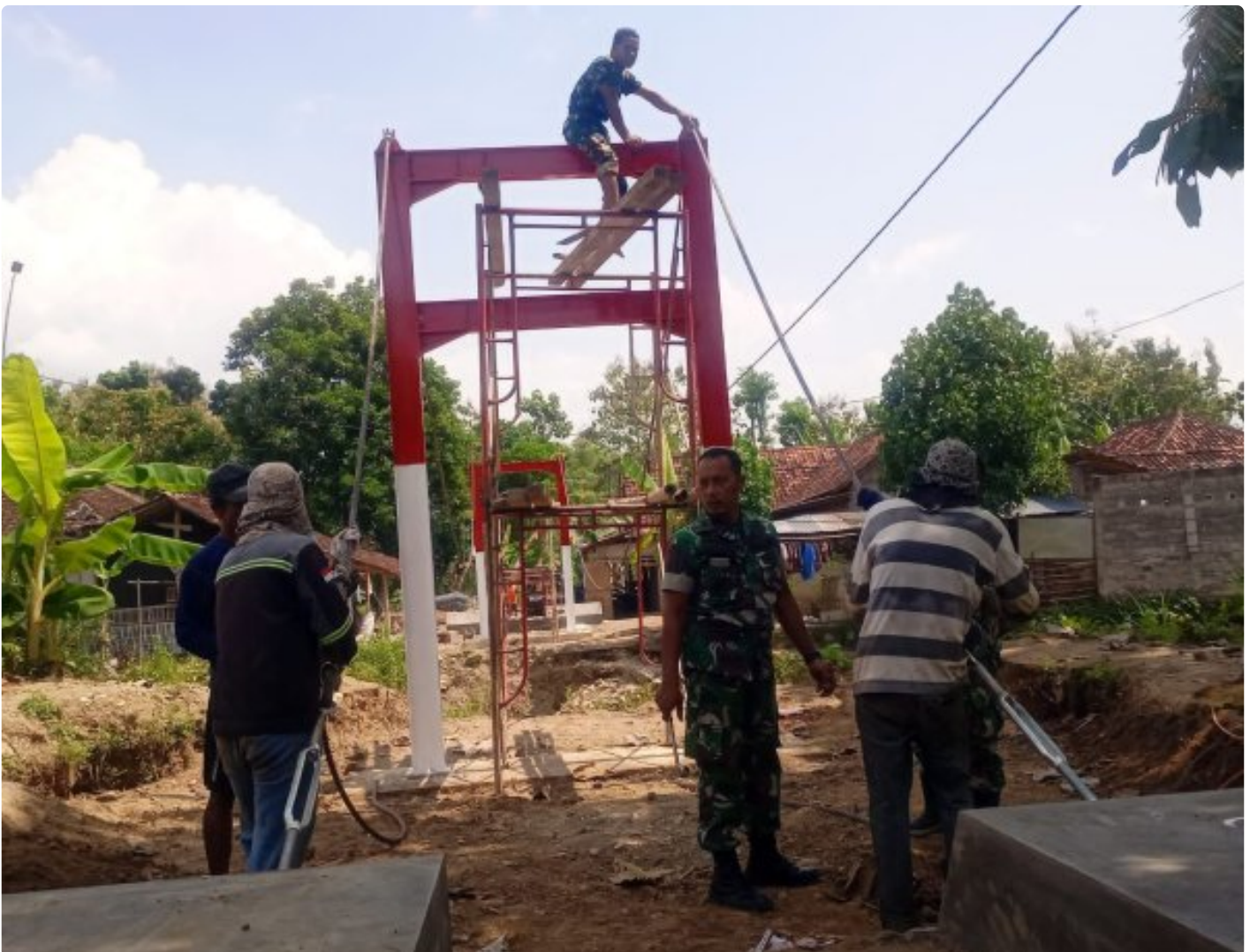
Danramil Bayat Turun Langsung Pemasangan Seling Baja Jembatan Gantung Garuda
