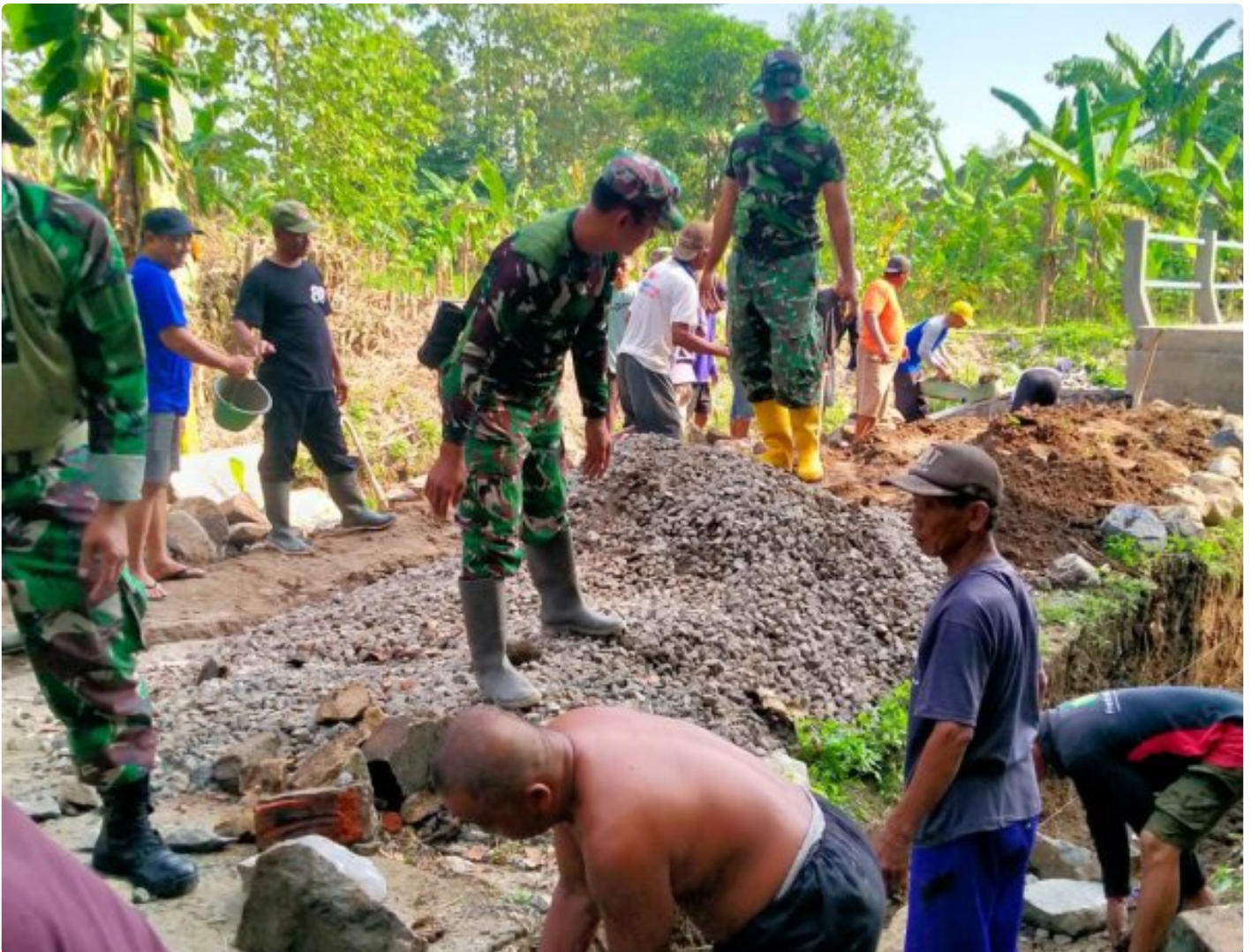
Babinsa Koramil 20/Cawas Bersama Warga Kerjakan Talud Jalan Menuju Jembatan Garuda Di Desa Burikan
