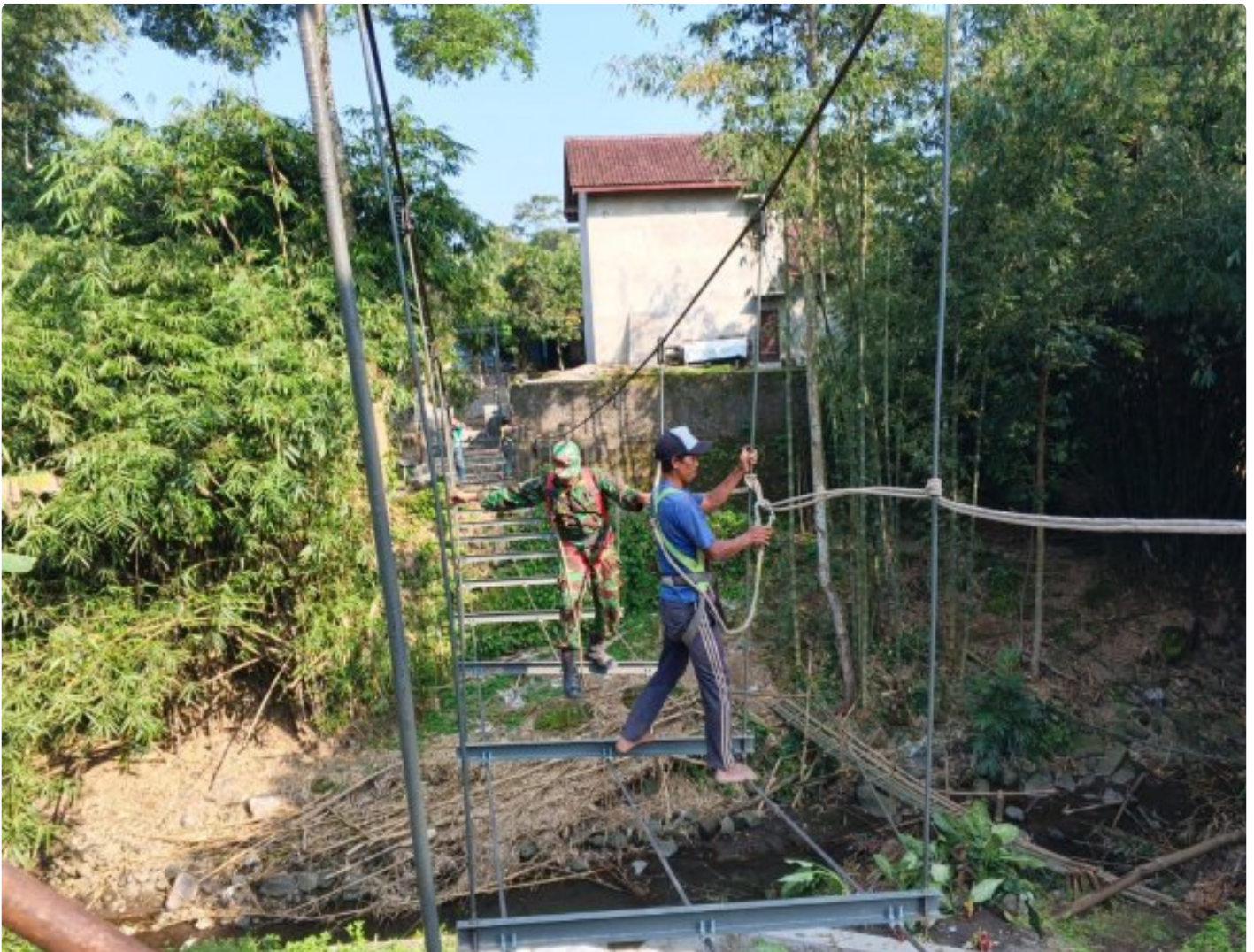
Babinsa Koramil 12/Manisrenggo Turun Langsung Bantu Pengerjaan Jembatan Gantung Garuda
