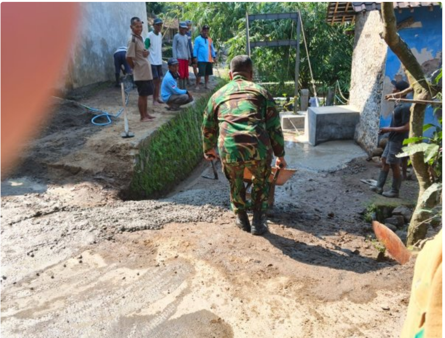
Babinsa Koramil 12/Manisrenggo Bersama Warga Gotong Royong Betonisasi Jalan Menuju Jembatan Gantung Garuda
